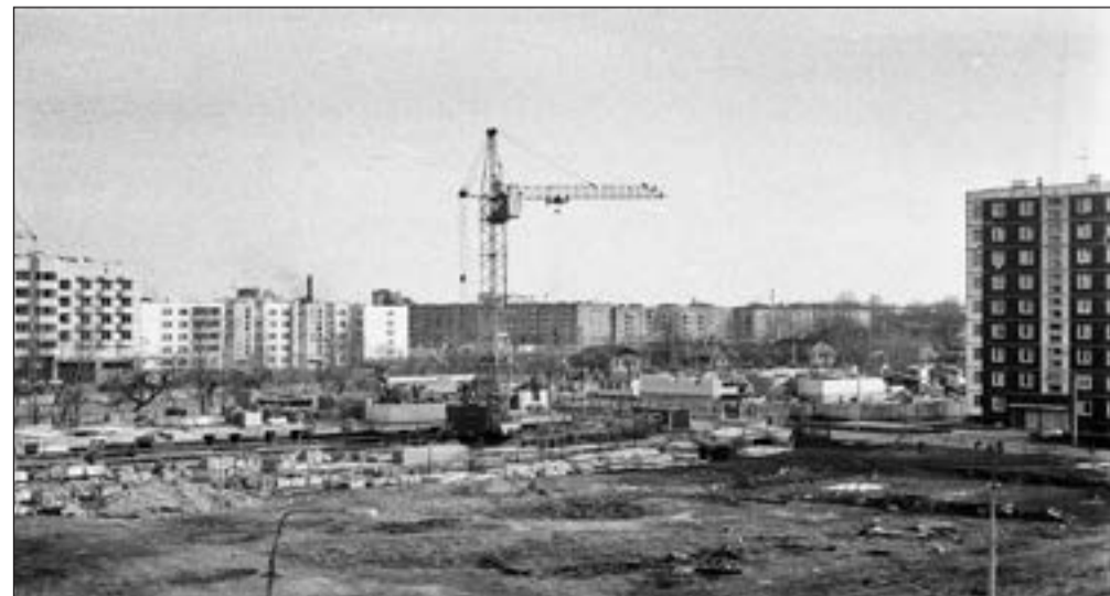
Гатчина. Середина 80-х. Микрорайон «Въезд». Строительство домов 50 и 46 по пр. 25 Октября.
